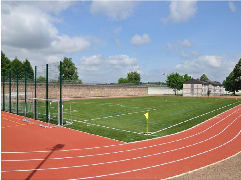
Die JVA Rockenberg verfügt über einen Sportplatz mit den Außenmaßen 80 Meter x 45 Meter. Es handelt sich hierbei um einen Kunstrasenplatz mit Quarzsand-Granulat-Gemisch. Ringsum ist der Platz von einer ca. 300 Meter langen Tartanbahn umgeben, wobei die Laufbahn auf der westlichen Längsseite zu einer 100 Meter-Bahn ausgebaut ist.
